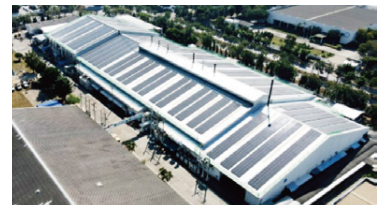
タイECTの工場に設置された太陽光パネル
